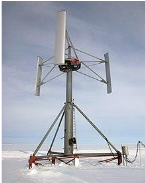
Aerogenerador de eje vertical tipo Darrieus en la Antártida.
