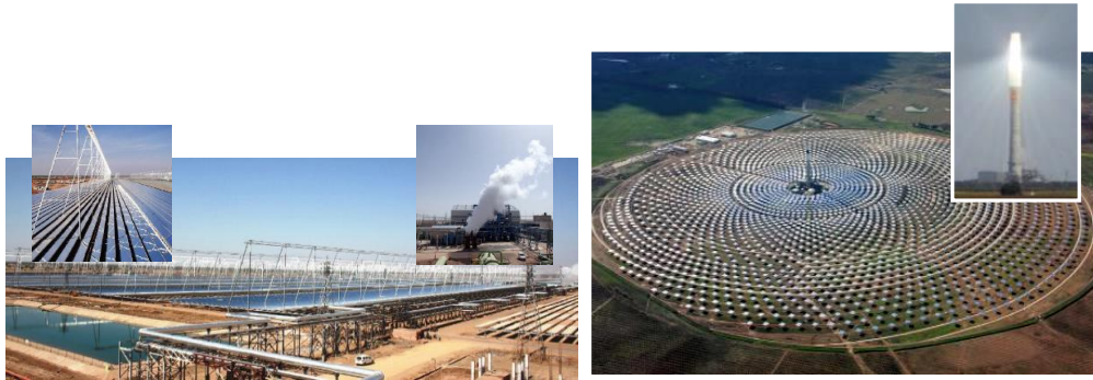
Figura 3. (de izquierda a derecha y de arriba abajo:) A) Solana, 250 MW con 6 h. de almacenamiento en Arizona (USA) es, aún, la central termosolar más grande del mundo; B) Manchasol 1&2, 50 MW con 7,5 horas de almacenamiento en Ciudad Real. Como la norma no daba la tarifa a centrales mayores de 50 MW se dispusieron en varios emplazamientos en España 2 o 3 centrales juntas; C) 100 MW en Rajasthan (India). Ésta es la central termosolar de tipo Fresnel mayor del mundo; D) Gemasolar 20 MW con 15 horas de almacenamiento y receptor de sales fundidas en Fuentes de Andalucía (Sevilla), fue la primera planta comercial de este tipo y sigue siendo la referencia que marca la tendencia de los nuevos proyectos de CST-E.
