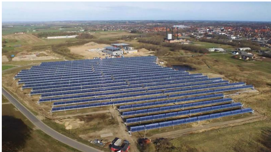
Figura 10 Colector de canal parabólico en Brønderslev, Dinamarca, con una capacidad instalada de 16,6 MWth. No solo suministra calor a la red de calefacción del distrito, sino también a la producción de electricidad.
