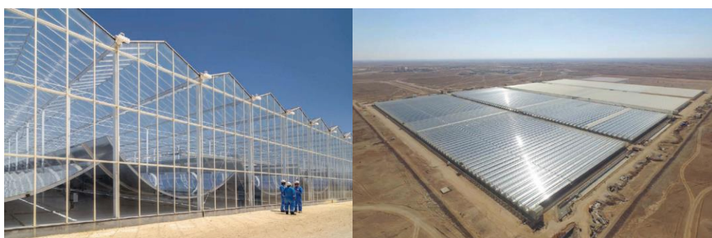
Figura 9. Planta solar Miraah para generación de vapor en la recuperación de petróleo en OMAN (fuente: IEA, [16])
